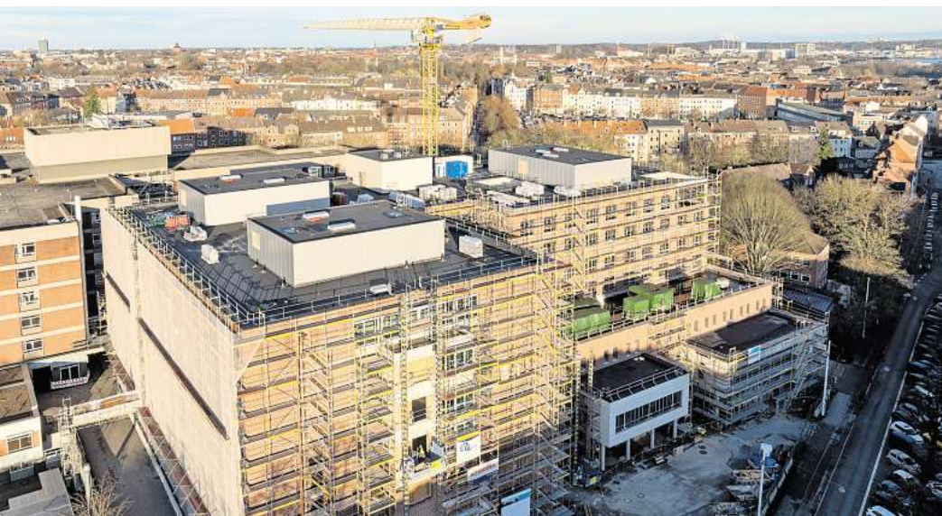
Bauarbeiten begleiten die Mitarbeitenden des SKK seit Jahren. Während hier noch der Neubau der Palliativ-Station zu sehen ist, beginnen bald die Abrissarbeiten der alten Wäscherei. Foto:Ulf Dahl
