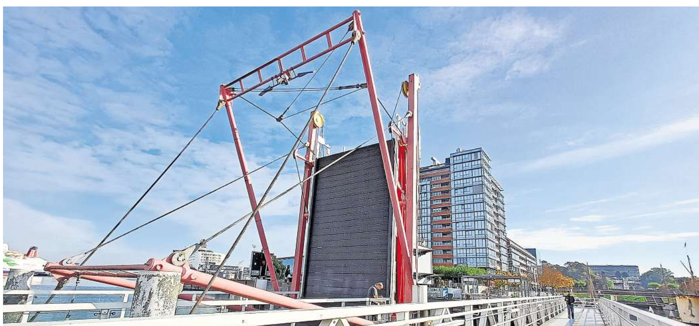
Schon seit fast genau einem Jahr verharrt die rote Klappbrücke zusammengeklappt und offen, während der Fuß- und Radverkehr über die weiße Verschiebbrücke läuft. Foto: Jan Köster
