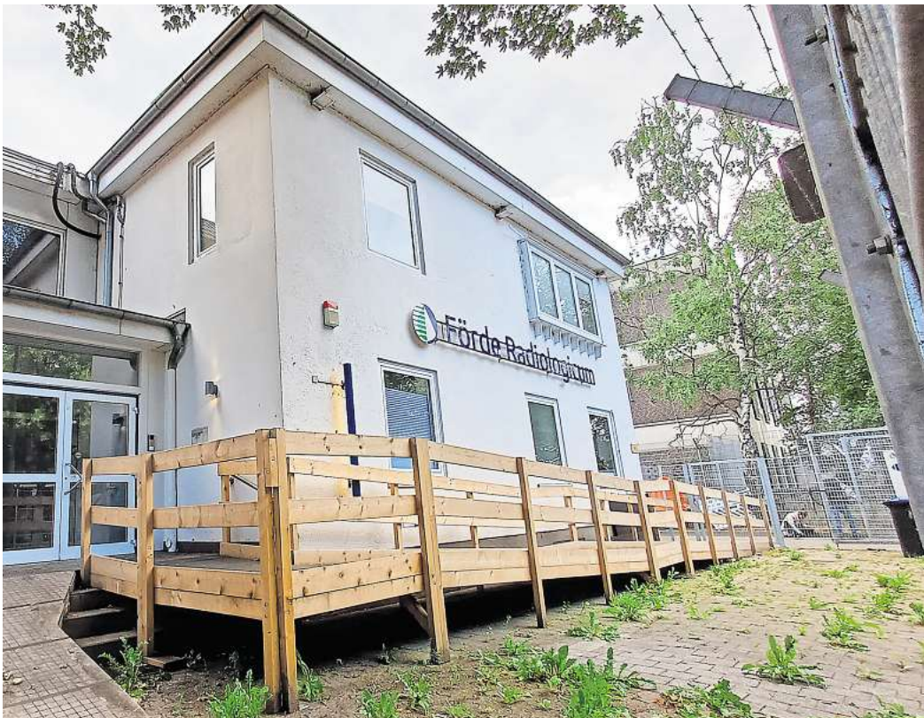
Der Treffpunkt auf dem Hof des ehemaligen „Förde Radiologicums“ im Karlstal wird bisher gut angenommen. Foto: kst
