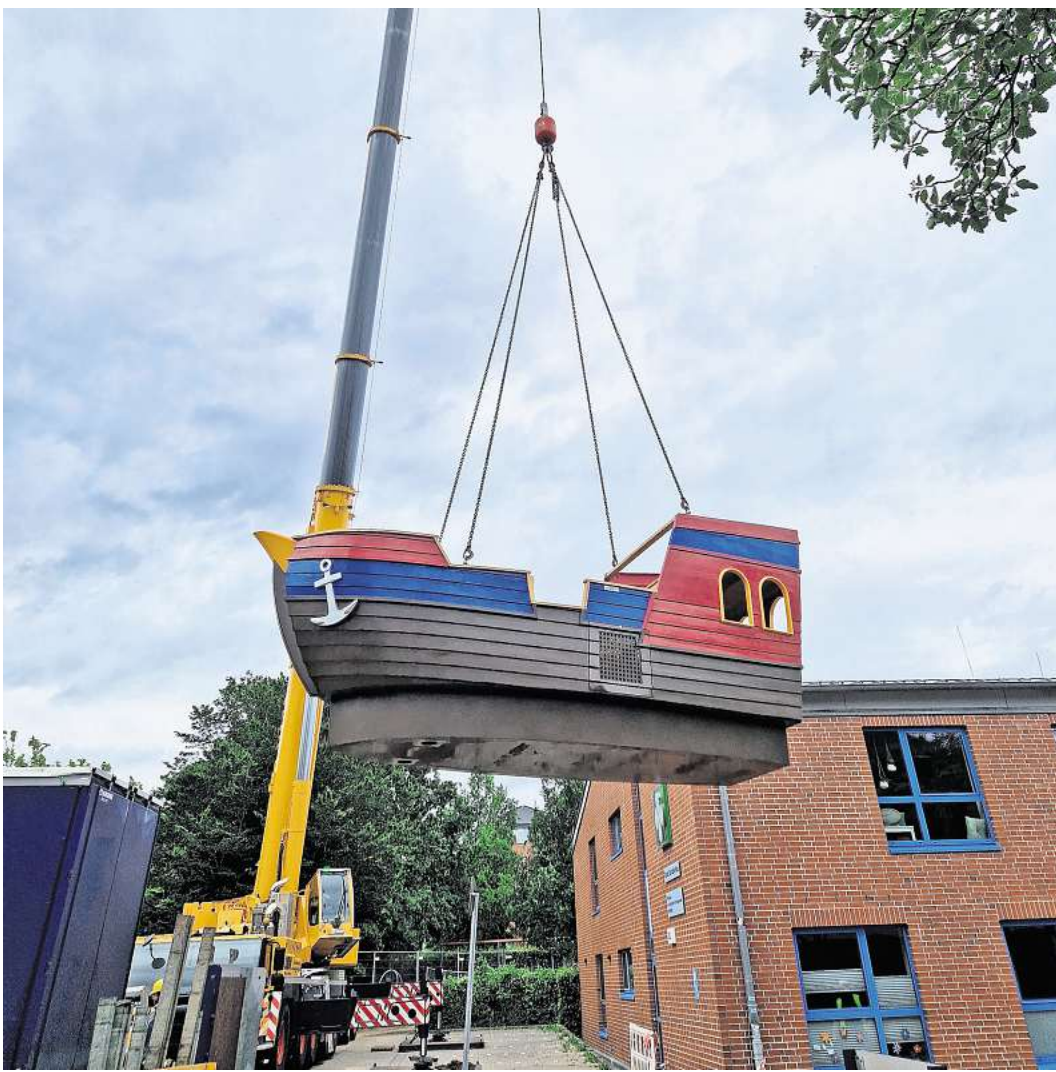
Ein großer Mobilkran war nötig, um das rund 3,5 Tonnen schwere Spielschiff vom Lkw auf die Außenfläche der Kita zu heben.
