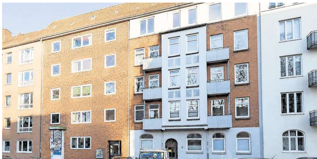
Eine notwendige Sanierung eines ganzen Hauses stellt viele Eigentümer oft vor finanzielle, zeitliche und nervenaufreibende Probleme. Für die beiden Kieler beginnt hier ihre Passion. Foto: WWS
