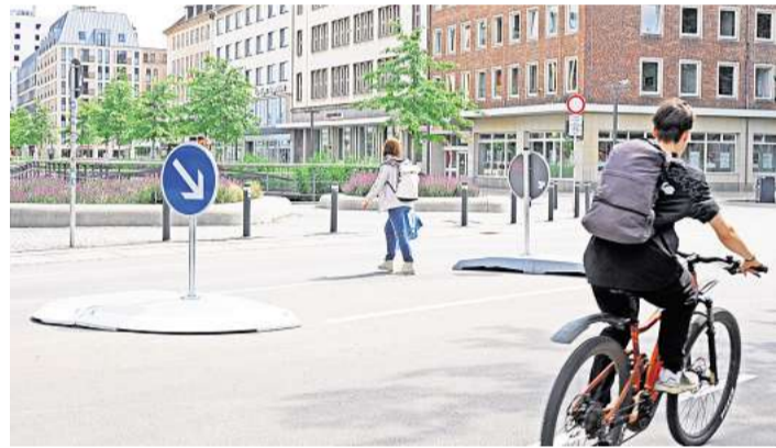
Die Elemente der Querungshilfe im Martensdamm wurden provisorisch direkt auf die Fahrbahnoberfläche montiert.
