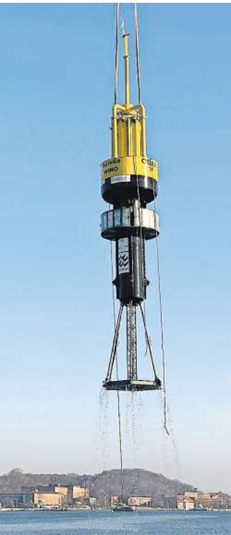
Das Kraftwerk am Kranhaken. Schwimmend ragt fast nur der gelbe Teil aus dem Wasser heraus.
