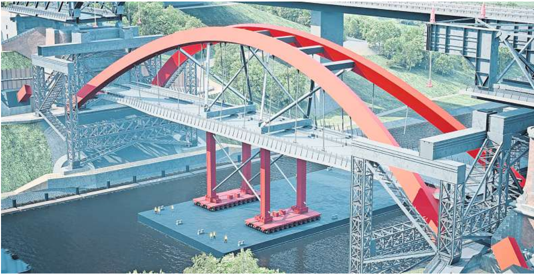
In nur 48 Stunden soll im Sommer 2027 die neue Brücke eingehoben werden. Der Kanal ist in dieser Zeit voll gesperrt.
