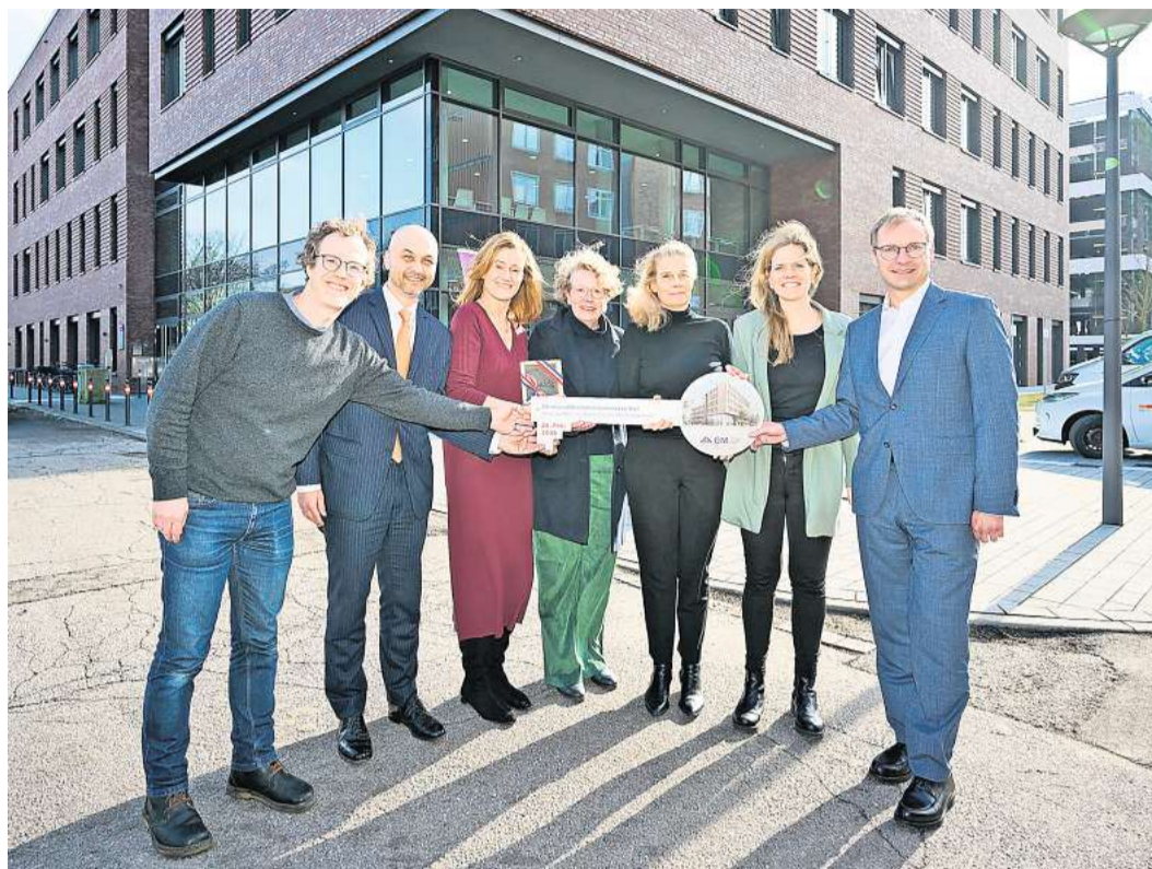
Mit einem Festakt mit Vertreterinnen und Vertretern aus Wissenschaft, Politik und öffentlicher Hand ist das neue Gebäude für die Agrar- und Ernährungswissenschaftliche Fakultät (AEF) seiner Bestimmung übergeben worden.
