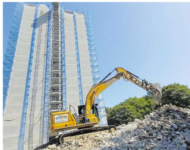
Links: Am Fuß des Gebäudes schüttert ein Bagger die Abrissstrümmen zu einem Sockel auf, von dem aus bald der große „Longfront-Bagger“ den Abriss übernehmen soll. Oben: Von der halb abgerissenen zehnten Etage aus reicht der Blick immer noch weit über Kiel. Unten: Zwei solcher ferngesteuerter Abriss-Roboter haben im Verlauf der vergangenen Wochen die obersten Etagen des Abbruch-Hochhauses klein gemacht.
