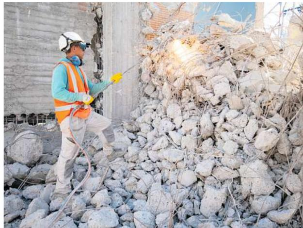
Wenn der Beton geknackt ist, müssen teilweise noch die darin enthaltenen Stahldrähte mit dem Brenner durchtrennt werden, damit die Trümmer abtransportiert werden können.
