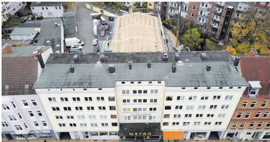
Von der Holtenauer Straße aus ist von den umfangreichen Arbeiten kaum etwas zu bemerken. Auf dem großen Kino-Anbau auf der Rückseite des Gebäudes ist inzwischen aber bereits der komplette neue Dachstuhl errichtet.
