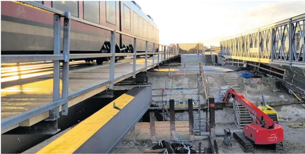
Behelfsbrücken überspannen den Bereich, in dem die Widerlager für die neue Levensauer Hochbrücke entstehen.
