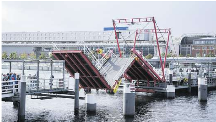
Die Hörnbrücke ist ein Wahrzeichen geworden, allerdings eines mit komplexer, störanfälliger Technik
