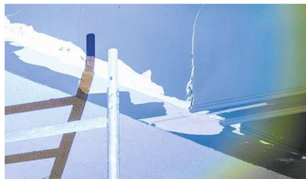
Die bei der Renovierung entdeckten Risse führten zu einer genauen Untersuchung der Deckenkonstruktion des Kinosaals.
