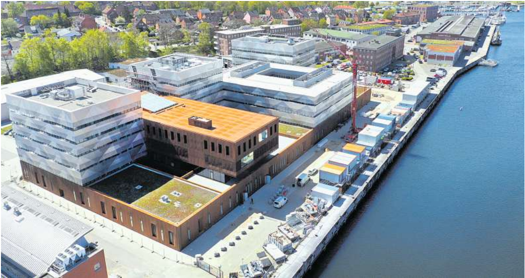
Nach insgesamt 20 Jahren Planungs- und sieben Jahren Bauzeit wurde der Geomar-Neubau am Ufer der Schwentinemündung jetzt offiziell eingeweiht.
